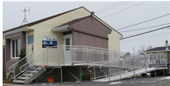
L'Association a récemment installé une nouvelle rampe d'accès au bureau d'immatriculation de Trois-Pistoles. Il était devenu nécessaire de remplacer la rampe en béton qui montrait plusieurs signes d'usure. La nouvelle rampe en aluminium a été conçue sur mesure pour répondre aux normes actuelles de la construction. Cette rampe permet un accès élargi et sécuritaire à l'ensemble de nos bureaux.
